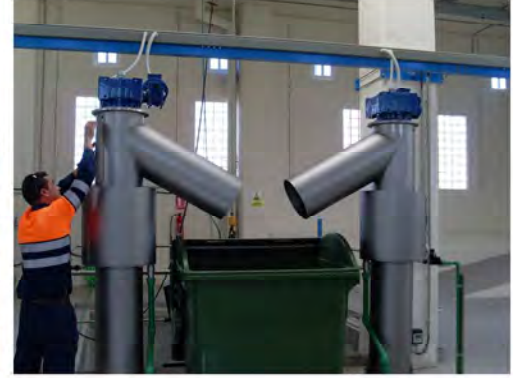
STATIONS DE POMPAGE
